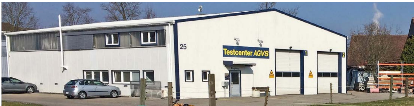
Le centre de test de l'UPSA de Zofingue.
