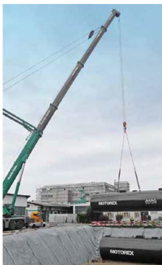
Motorex construit un nouvel entrepôt à citernes à Langenthal.
